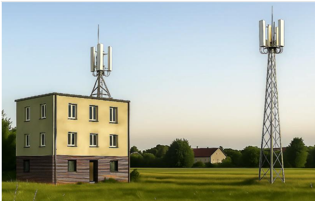
Rysunek 4. Stacje bazowe telefonii komórkowej: zainstalowana na dachu budynku oraz wolnostojąca Źródło: opracowanie własne
